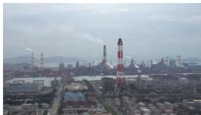
大規模災害時の構内 確認（非防爆エリアから のズームアップ）
