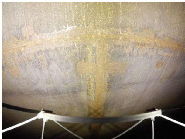
壁面の溶接線
